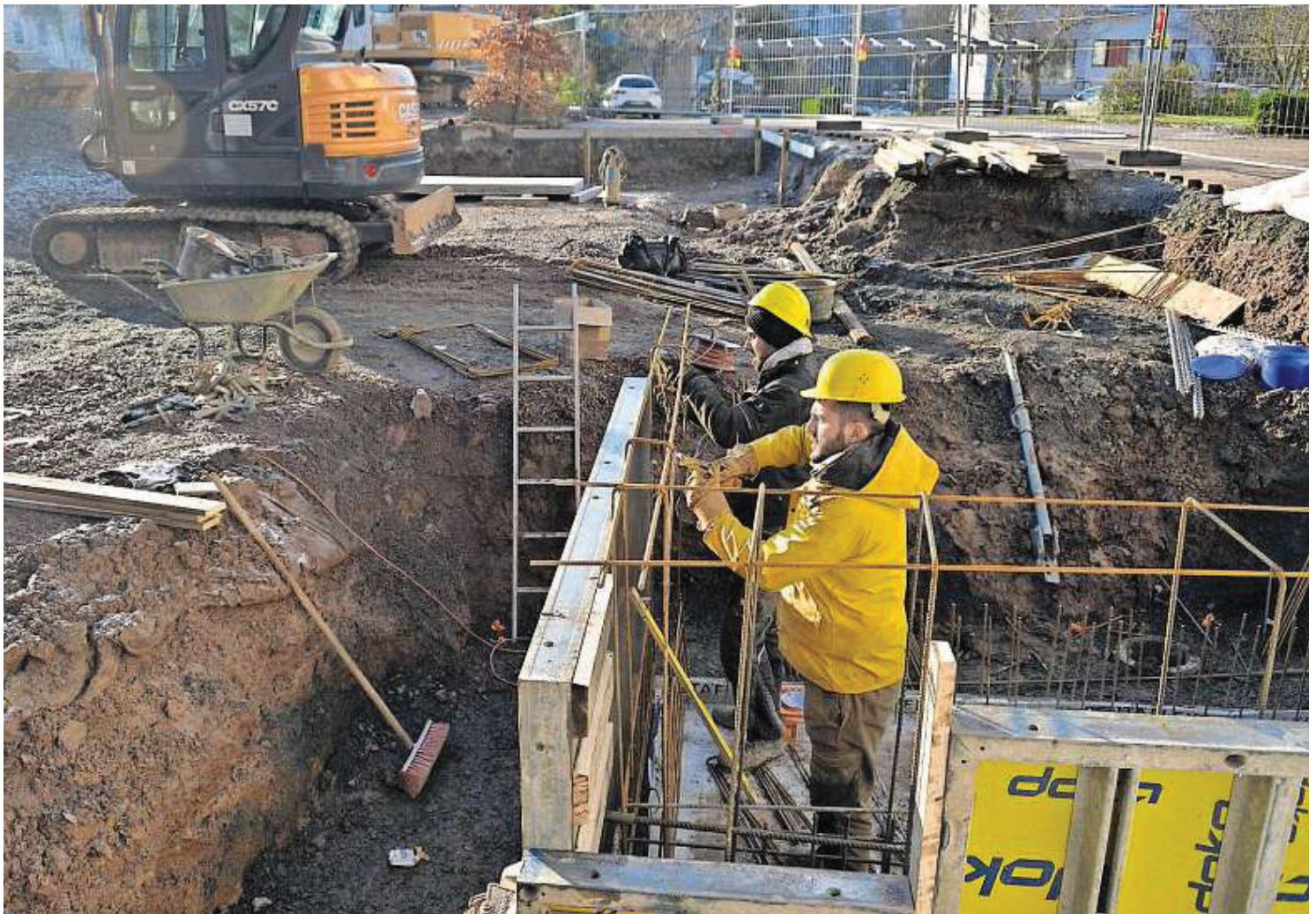
Wenn das Wetter mitspielt, soll das Gebäude Ende 2019 fertig sein und 2020 in Betrieb genommen werden. In ihm finden vier Praxen im Erdgeschoss und zehn Pflegebetten im Obergeschoss Platz.
